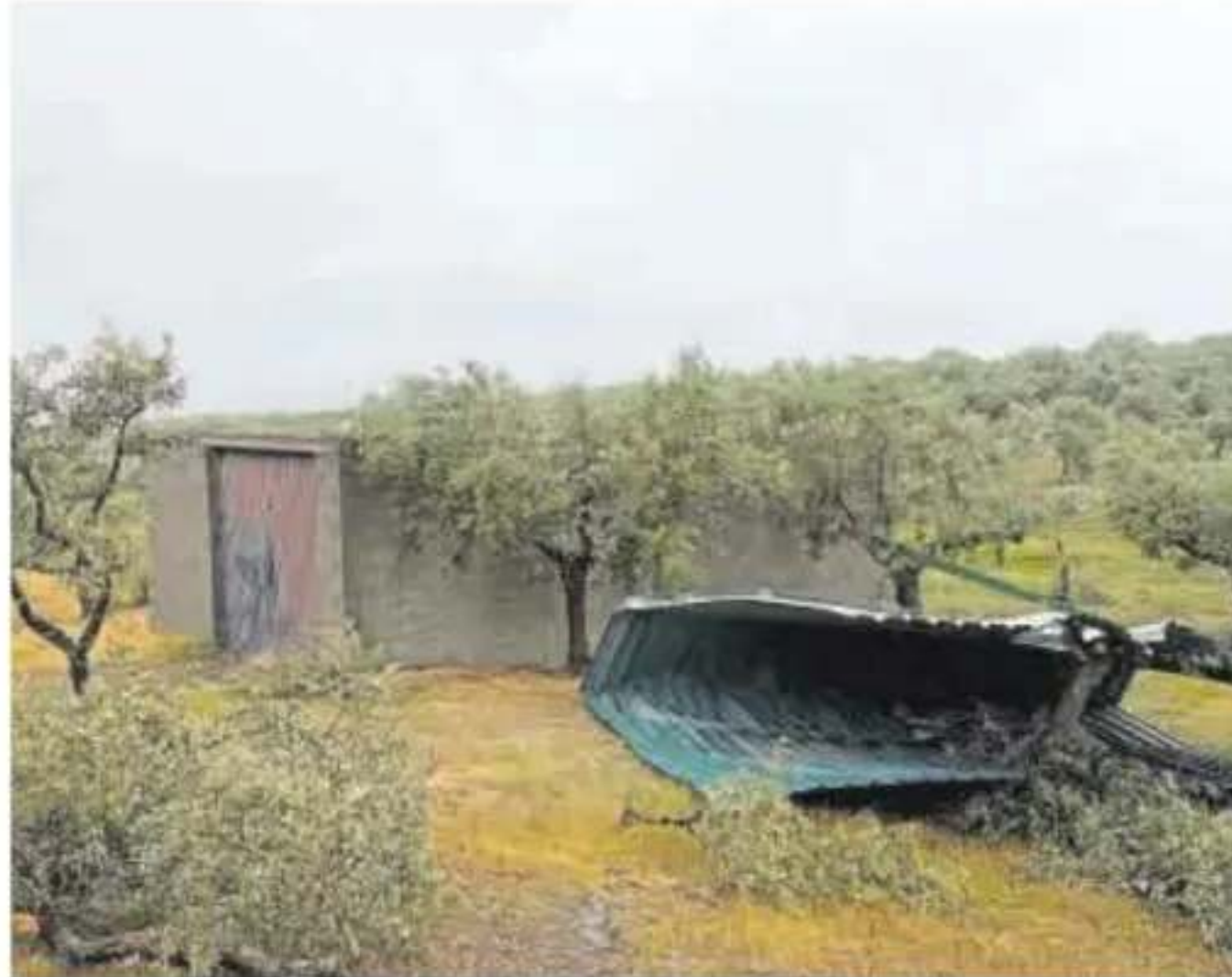
Daños del tornado.
